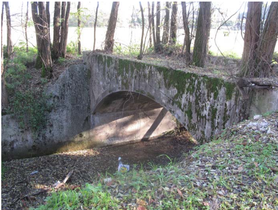
Foto 1_03-attraversamento stradale 1_AS_3 in prossimità del Molini della Valle
