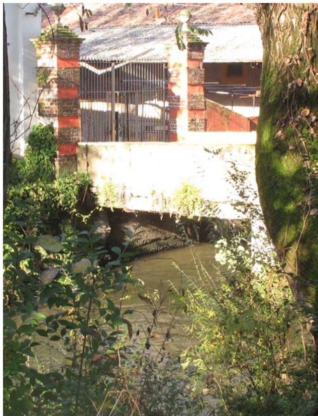
Foto 1_04 - attraversamento stradale 1_AS:02 in prossimità del molino della Valle
